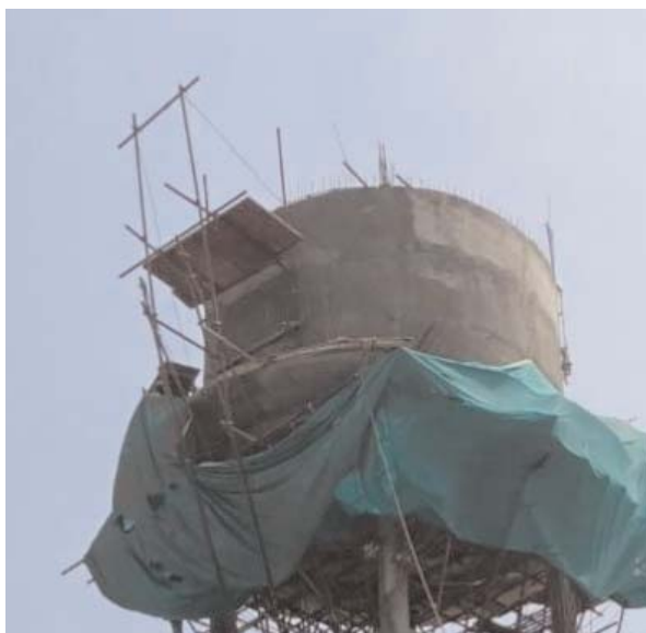
500 किलोलीटर क्षमता के दो ओवरहेड टैंक भी बनाये जा रहे हैं। इनका निर्माण तेज गति से चल रहा है। नेमावर के साथ-साथ खातेगांव नगर परिषद क्षेत्र में नर्मदा जल की आपूर्ति
